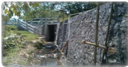
Dinding penahan tebing di Desa Umbulharjo sistem air limbah komunal
